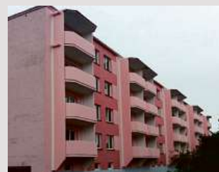
→ Realizace přistavěných lodžií - náhrada balkonů lodžiemi
