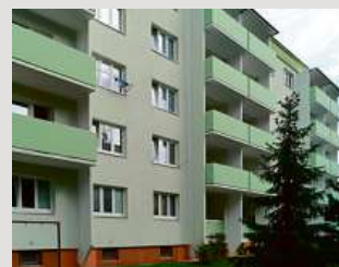
→ Realizace přistavěných lodžií - prodloužení původních lodžií
