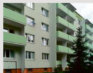
→ Realizace přistavěných lodžií - prodloužení původních lodžií
