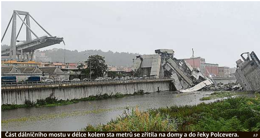
Část dálničního mostu v délce kolem sta metrů se zřítila na domy a do řeky Polcevera. AP
