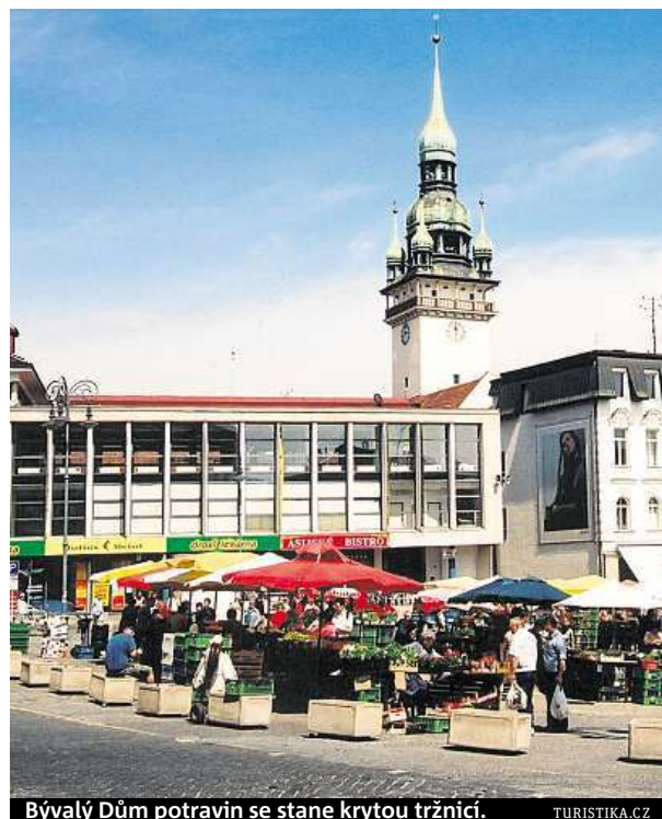
Bývalý Dům potravin se stane krytou tržnicí.
