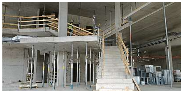
Současný stav vstupní haly METRO
