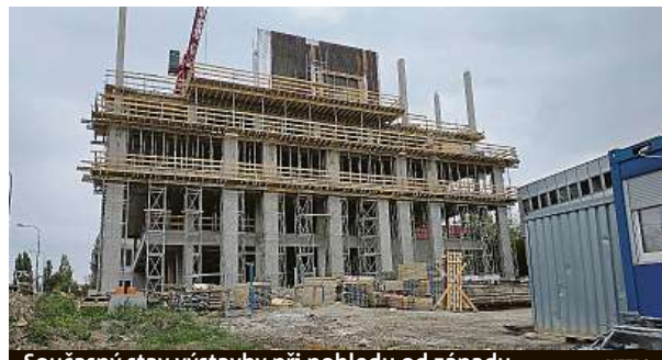
Současný stav výstavby při pohledu od západu METRO
