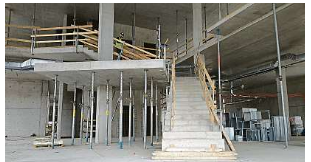
Současný stav vstupní haly METRO
