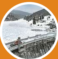
Hráz přehrady Labská vysoká 41,5 metru a dlouhá 153,5 metru
