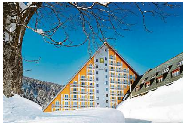
Budovy hotelu Pinia vznikly mezi roky 1977 až 1981, architektem byl Karel Schmieď. Jde o jednu z největších staveb Krkonoš.
