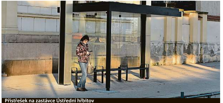
Přístřešek na zastávce Ústřední hřbitov
