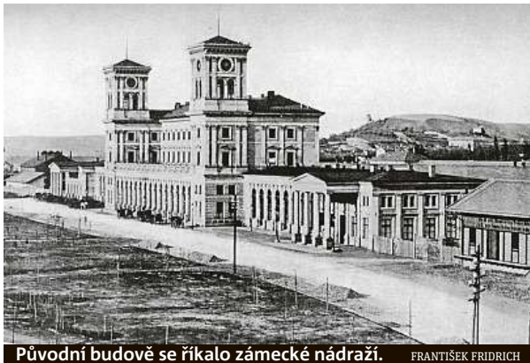
Původní budově se říkalo zámekové nádraží. FRANTIŠEK FRIDRICH
