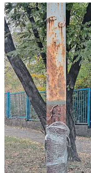
Na jedné z fotek sloupů chybí nová patice. 3x RICHARD HLADÍK
