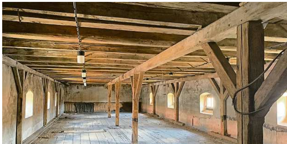
Interiéry budou podpiřat nové i zrestaurované trámy. V restauraci budou kamenné klenby.
