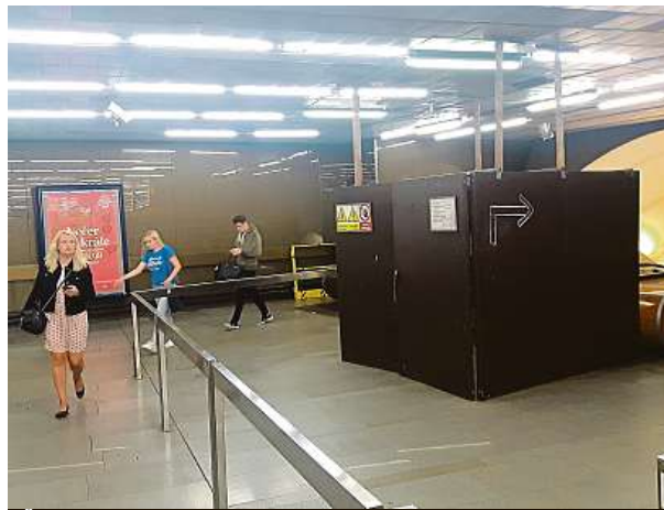
Šipka na bedně chce dopravce vyměnit za ceduli. 3X METRO
