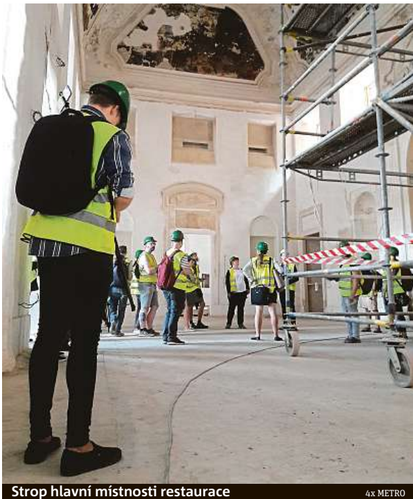
Strop hlavní místnosti restaurace
