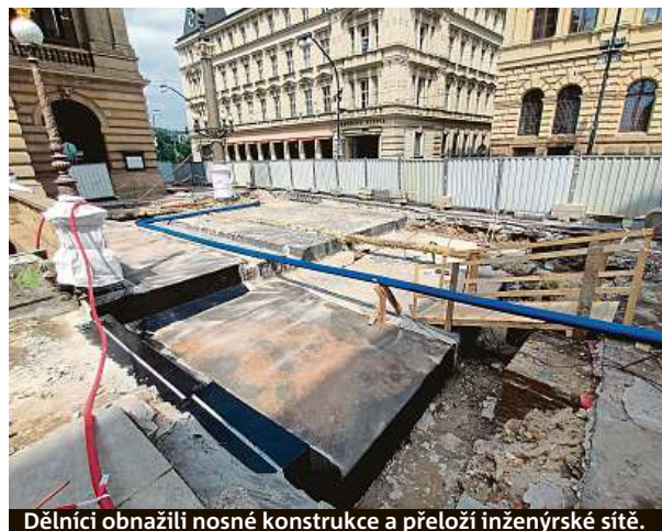
Dělníci obnažili nosné konstrukce a přeloží inženýrské sítě.
