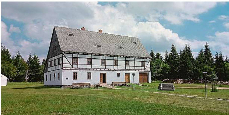
Hrázděná stavba v horském areálu Lesná je novostavba. Slouží jako muzeum života a práce krušnohorských obyvatel v dávných dobách, najdete tu původní předměty z jejich již neexistujících domovů.
