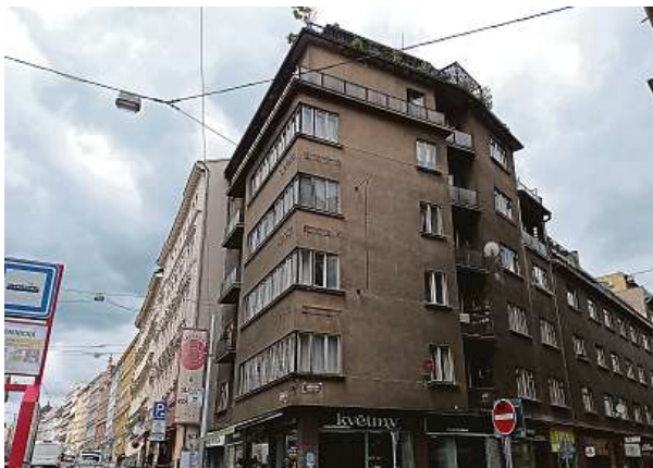
Pohled na dům na rohu třídy Milády Horákové a Haškovy ulice od tramvajové zastávky Kamenická
