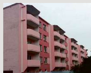
→ Realizace přistavěných lodžií - náhrada balkonů lodžiemi
