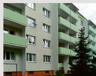
→ Realizace přistavěných lodžií - prodloužení původních lodžií
