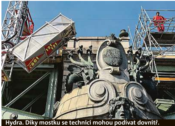
Hydra. Díky mostku se technici mohou podívat dovnitř.
