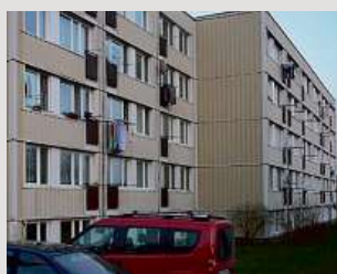
Původní stav bytového domu - francouzská okna bez balkonů
