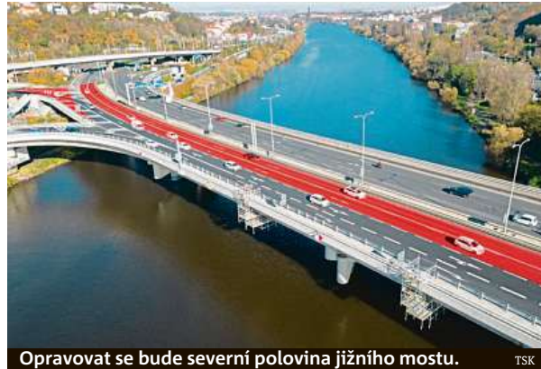
Opravovat se bude severní polovina jižního mostu. TSK
