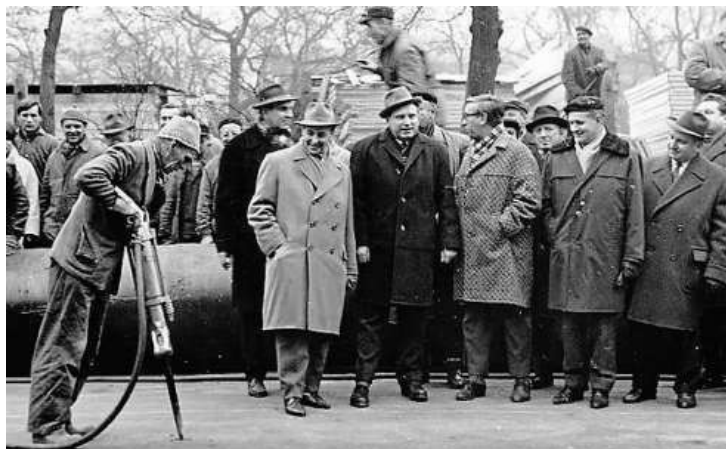
Začátek stavby metra v Bolzanově ulici nedaleko Hlavního nádraží
