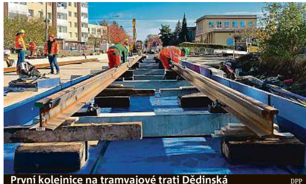
První kolejnice na tramvajové trati Dědinská
