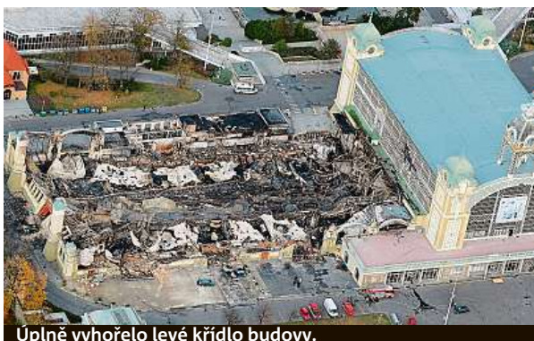
Uplně vyhořelo levé křídlo budovy.
