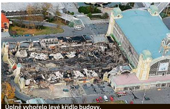
Uplně vyhořelo levé křídlo budovy.
