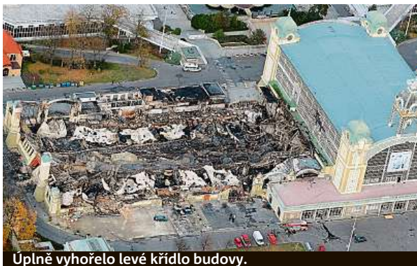
Uplně vyhořelo levé křídlo budovy.
