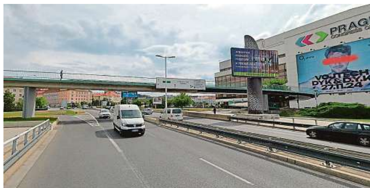
Lávka na Pankráci přechází Severojižní magistrálu. Je ocelová, skříňového průřezu, s točitými rampami. TSK hl. m. Prahy ji eviduje pod číslem X-551.
