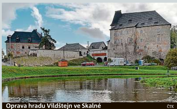
Oprava hradu Vildštejn ve Skalné
