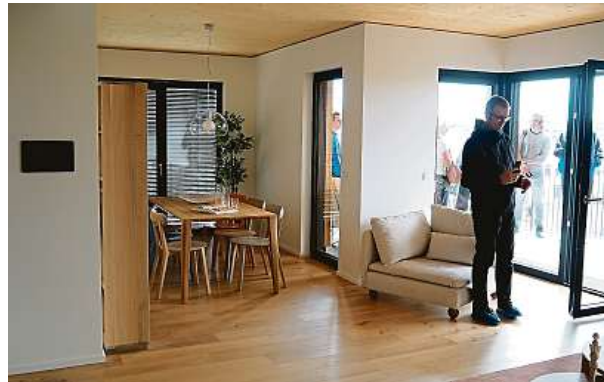
Všechny stěny jsou dřevěné, jedná se o modřínové desky, ale kvůli tepelné a hlukové izolaci mají speciální omítku.
