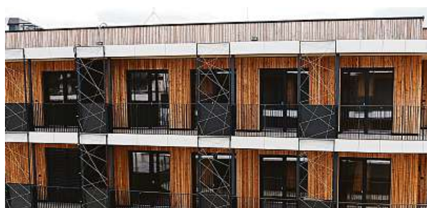
Dřevěný plášť na střeše zesvětľal, je vystavený povětrnostním vlivům víc než obložení v lodžích bytů. Jejich odstín by se měnit neměl.
