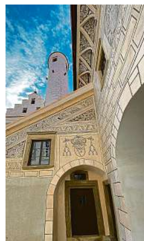
Červená Řečice prošla 12letou rekonstrukcí. PETRA VINCE
