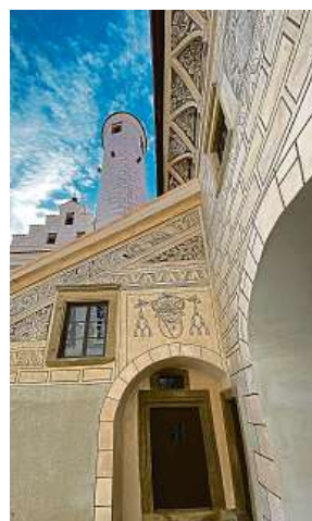
Červená Řečice prošla 12letou rekonstrukcí. PETRA VINCE
