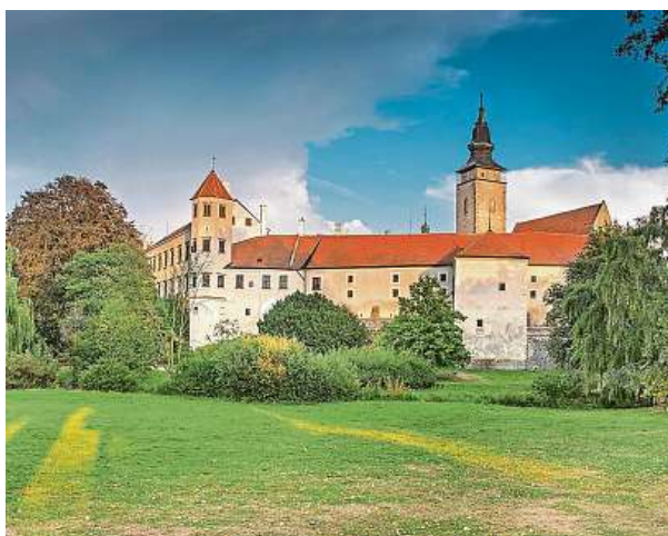
Méně obvyklý pohled na renesanční skvost jihočeské Telče. Zámek prošel v posledních letech výraznou rekonstrukcí. 2x ALEŠ MOTEJL
