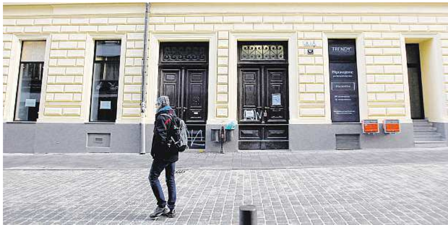
Loni třeba skončila rekonstrukce bývalé pošty. MAFA
