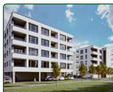
Bytové domy Břeclav, ul. Charvátská
