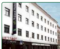
eFi Palace Hotel, Brno, dokončené 2 etapy
