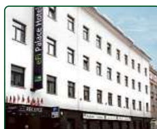
eFi Palace Hotel, Brno, dokončené 2 etapy
