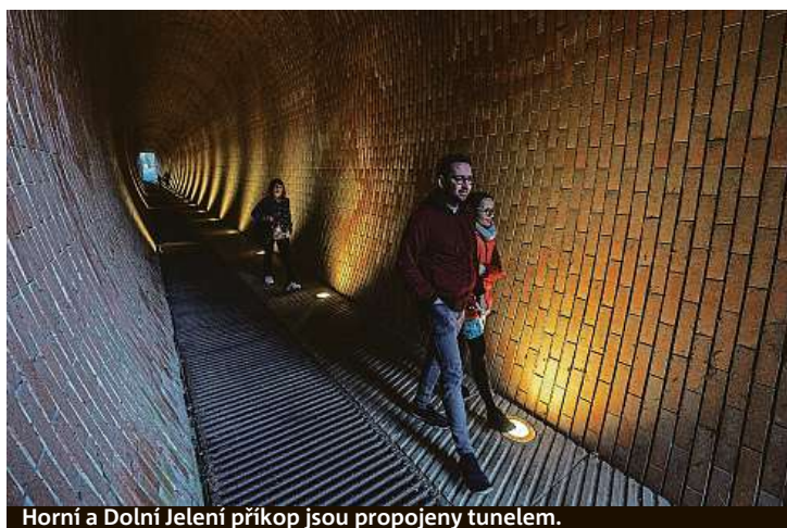
Horní a Dolní Jelení příkop jsou propojeny tunelem.
