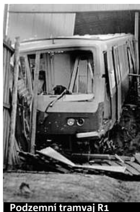
Podzemní tramvaj R1
