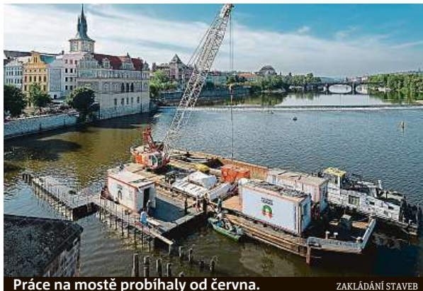
Práce na mostě probíhaly od června.
