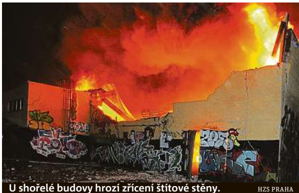
U shořelé budovy hrozí zřícení štitové stěny.
