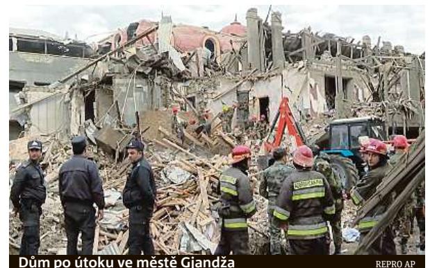
Dům po útoku ve městě Gjandža
