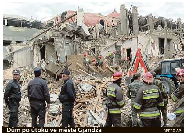
Dům po útoku ve městě Gjandža
