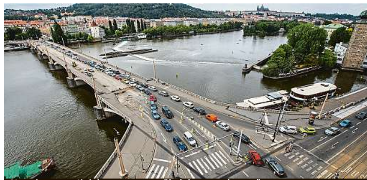
Nutná oprava Jiráskova mostu měla být provedena už v roce 2017.
