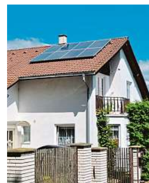
Ukázka montáže na klasickém domě se sedlovou střechou.
