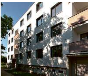
Bytový dům, Brno-Črlice
