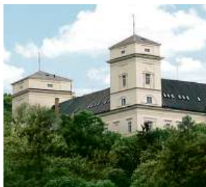
Zámek Račice, přestavba
