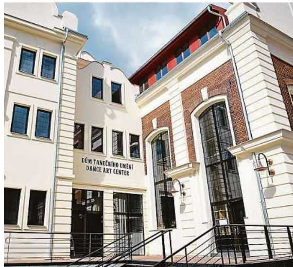
Dům tanečního umění Praha sídlí v bývalé budově pivovaru.
