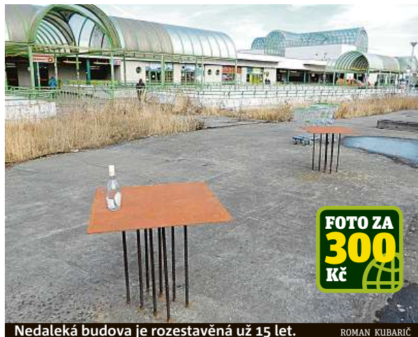
Nedaleká budova je rozestavěná už 15 let.
