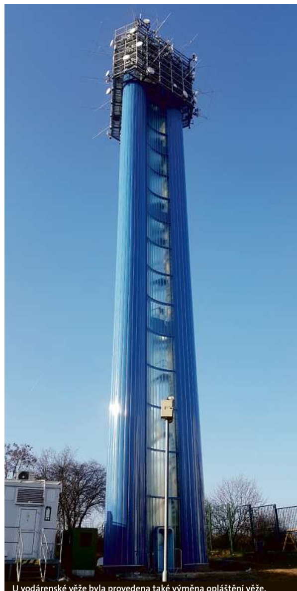
U vodárenské věže byla provedena také výměna opláštění věže.
