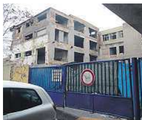
Budovu čeká demolice.
