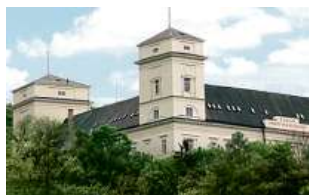
Zámek Račice, přestavba
